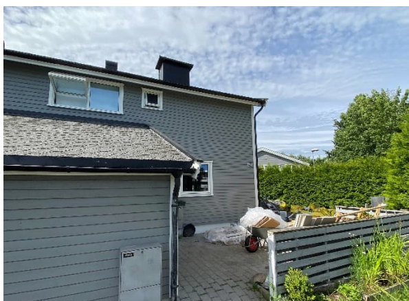
Ny kledning småhus
