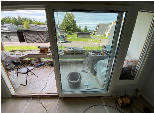
Nye skyvedørsfelt i blokker
