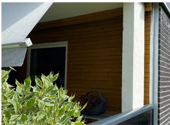
Royal impregnert kledning på balkonger
