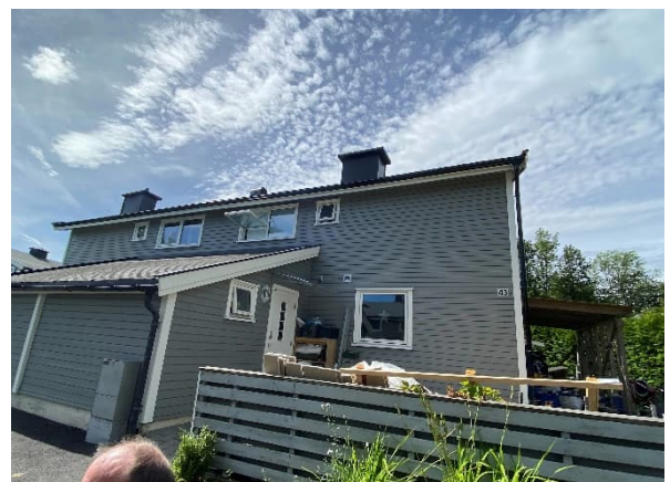
Ny kledning på småhus
