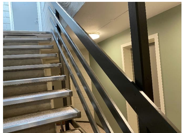
Rekkverk på to sider
