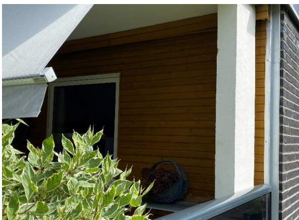
Royal kledning på balkonger
