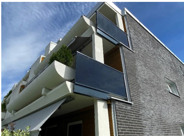
Renoverte balkonger med glass i gavlvegger
