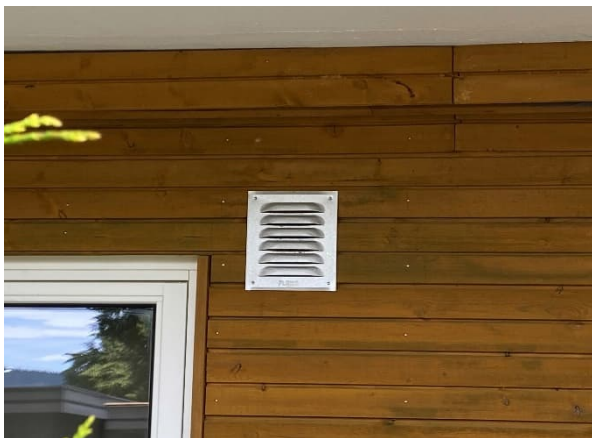
Ventil i vegg på blokk
