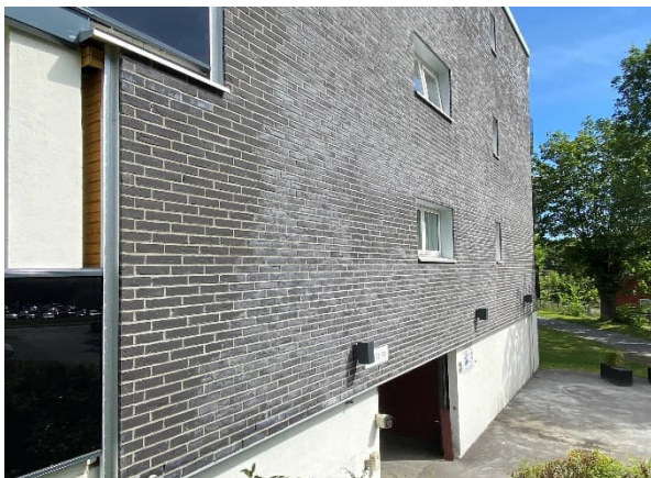
Teglstein satte gavlvegger på blokker
