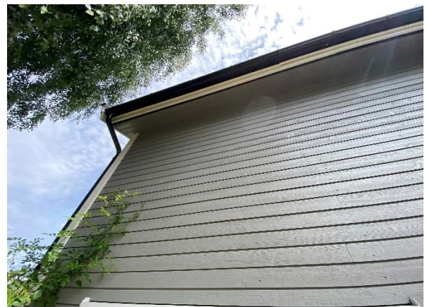
Ny kledning på småhus
