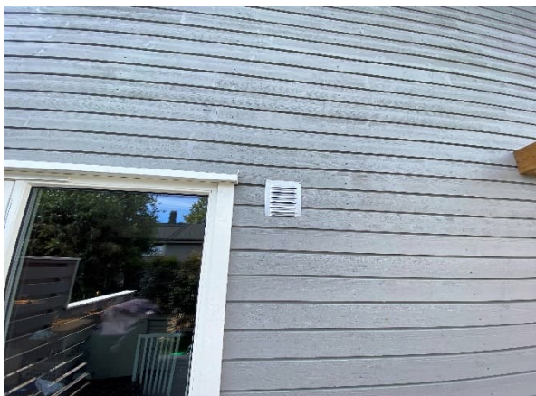
Ventilasjon i vegg på småhus
