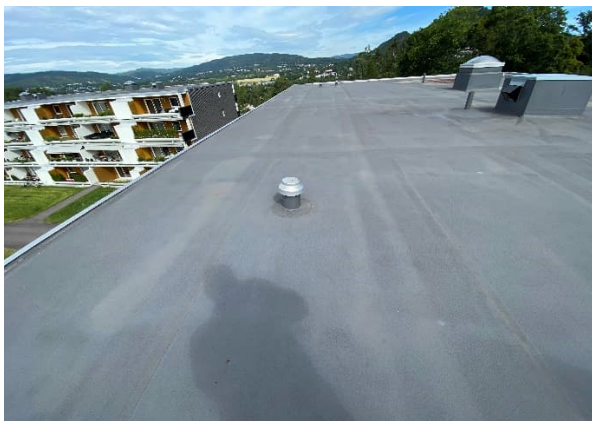
Folietekket tak- Blokker/ Steinlagt torg/tak under terreng
