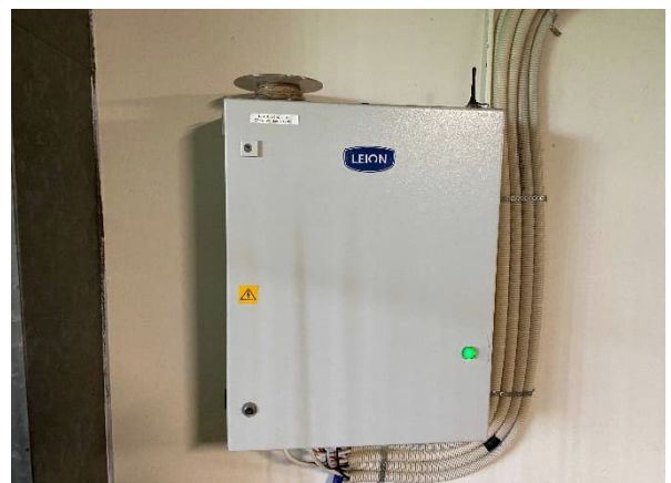
Underfordeling til katodisk beskyttelse
