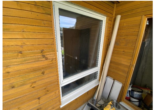
Nye vinduer i blokker
